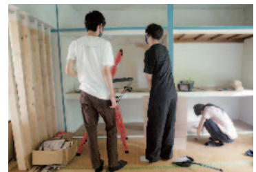
福岡市東区の団地リノベーションプロジェクト
