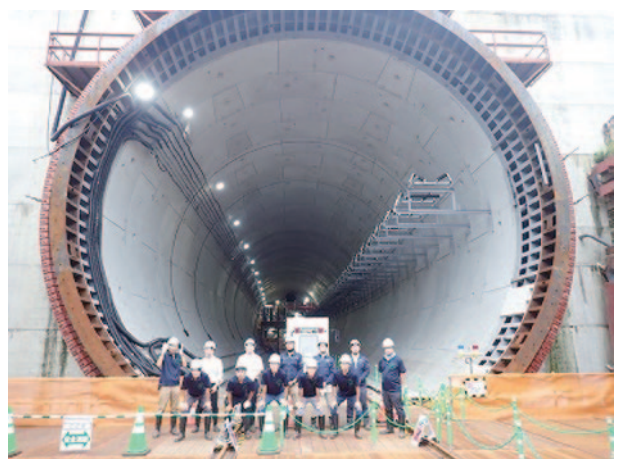
横浜湘南道路シールド工事現場見学
