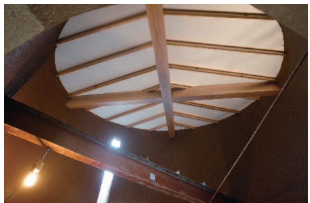
福間倉庫リノベーションプロジェクト
